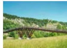
Abgeleitet vom uralten Prinzip der freihängenden Seilbrücke überspannt eine der längsten Holzbrücken Europas den Main-Donau-Kanal auf Höhe des Essinger Ortsteils Weihermühle. Die ungewöhnliche Konstruktion ist fast 200 Meter lang und hält pro Quadratmeter 500 Kilogramm aus. Gemeinde Essing, Tel. 09447/920093, [www.marktessing.de](http://www.marktessing.de)
